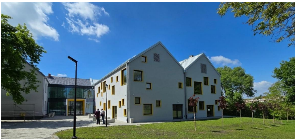
Budynek Szkoły Podstawowej w Ziemiećicach w trakcie rozbudowy, zbiór własny Urzędu Gminy
