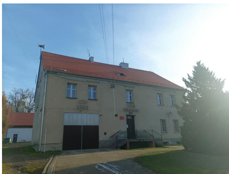
Zdjęcie: Budynek Domu Parafialnego w Łubiu po modernizacji pokrycia dachowego, zbiór własny Urzędu Gminy
