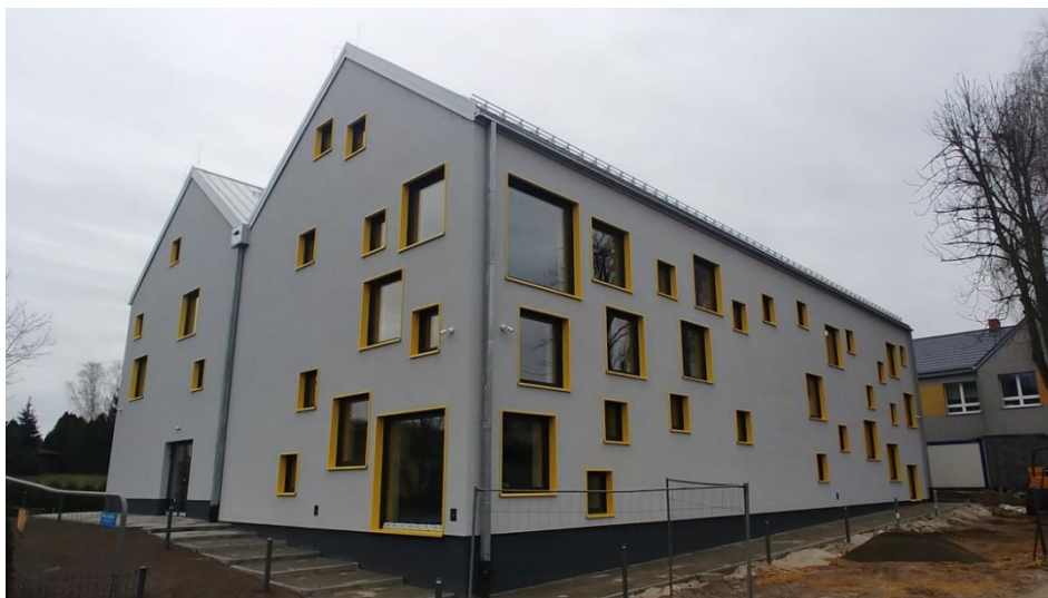
Zdjęcie: Budynek Szkoły Podstawowej w Ziemięcicach w trakcie rozbudowy, zbiór własny Urzędu Gminy
